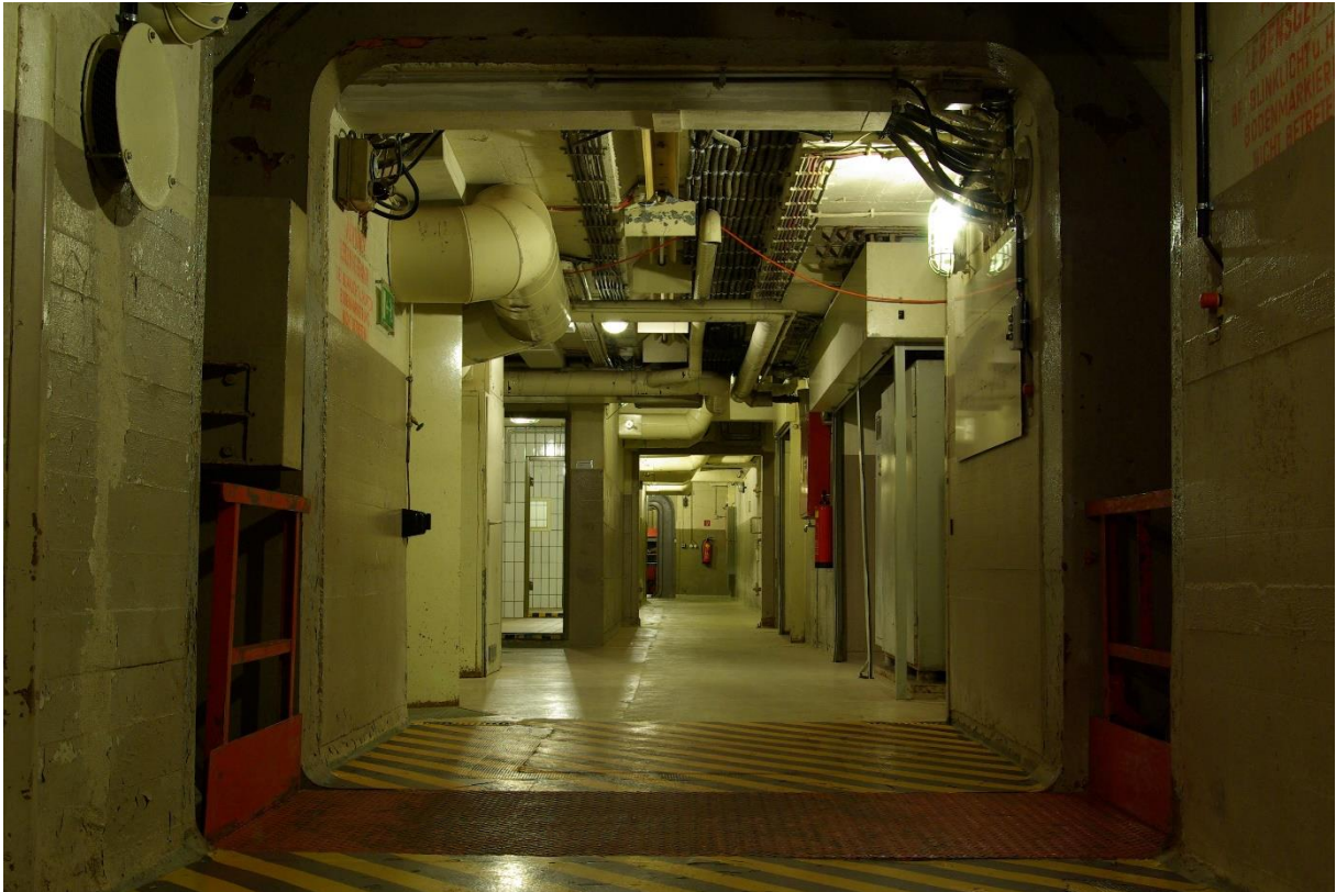
Eingangsperrbauwerk des Regierungsbunkers
